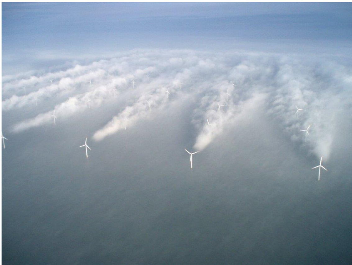
Figura 9: Efeito esteira em turbinas eólicas offshore em no parque eólico Horns Rev , na Dinamarca
