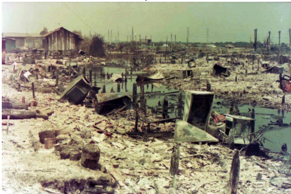
Registro fotográfico da Vila Socó após o incêndio. Fonte:
