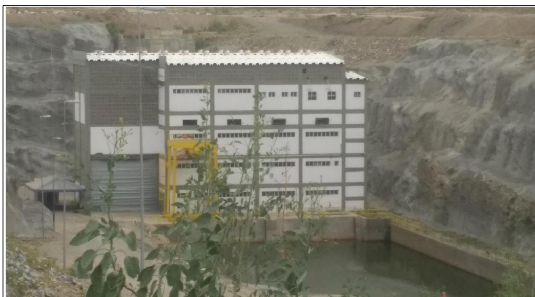
Figura 13. Estação de bombeamento do PISF.
