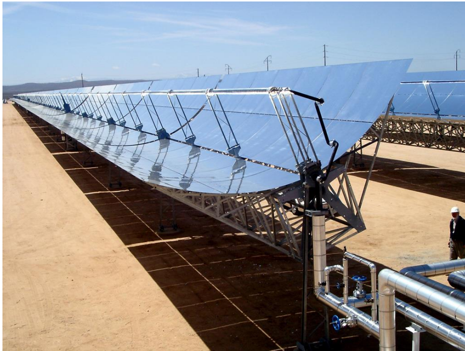
Figura 18 – Concentrador parabólico Fonte: RENEWABLE POWER NEWS (2009)
