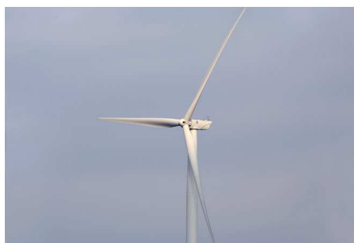
Figura 3 – Turbina eólica de eixo horizontal com 3 pás
