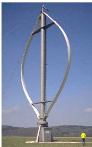
Figura 2 – Turbina Darrieus de eixo vertical
