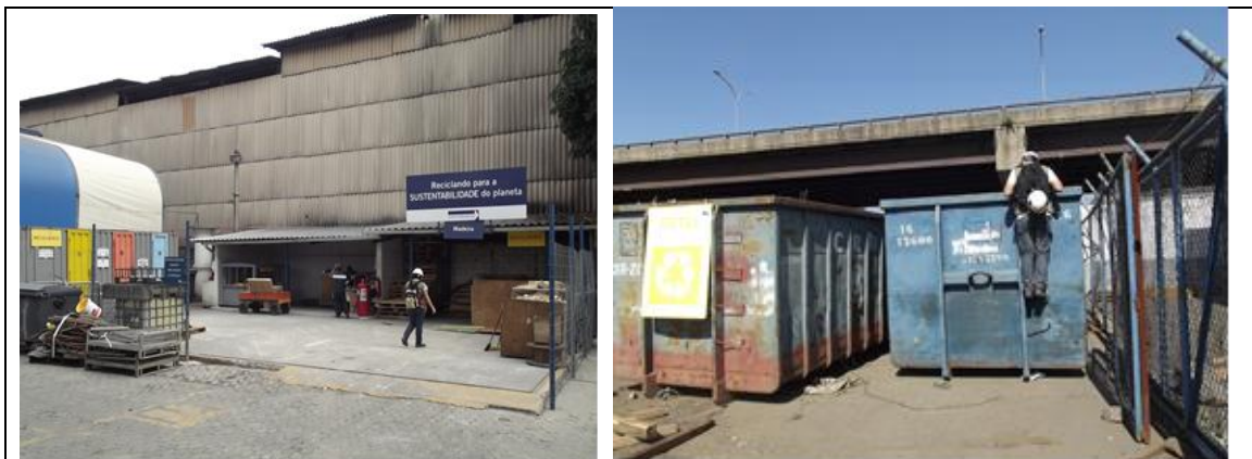
Figura 18- Instalações de armazenamento nas áreas arrendadas no Porto do Rio de Janeiro Fonte: IVIG/COPPE/UFRJ, 2013
