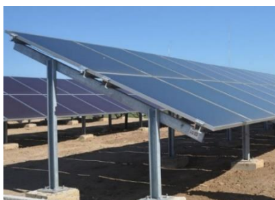
Figura 102: Estrutura montada com módulos FV
