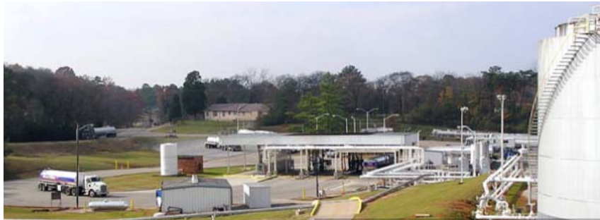
Figura 3.3: Wholesale Terminal Rack 1 Fonte: AEC, 2010.
