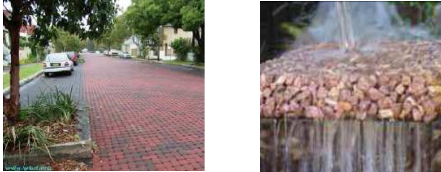
Figura 3.16: Tipo de pavimento poroso - Modular Hydropave (à direita) e Monolítico Permapave (à esquerda) Fonte: Monash University, (Deletic et al , 2010)
