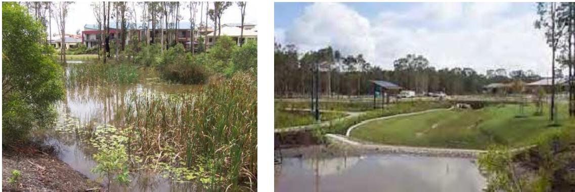
Figura 3.11 – Exemplos da aplicação de Alagados Construídos.
