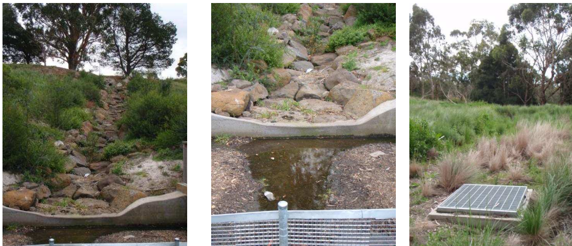
Figura II.B: Condução das águas pluviais (à esquerda), gradeamento (ao centro), e extravasor (à direita).
