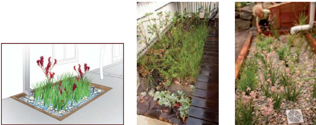
Figura 3.8 – Biofiltros encaixado no solo, adequados para projetos em escala de lote.
