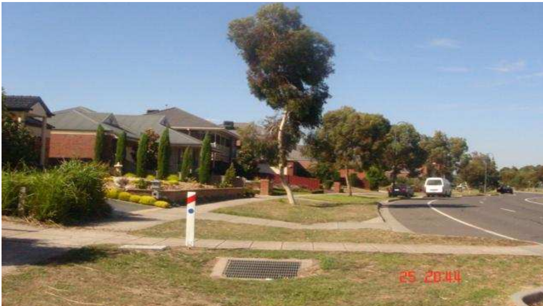
Figura I.B - Valas vegetadas de Biofiltração nas calçadas. Fonte: Nunes, R. T.S., 2010.
