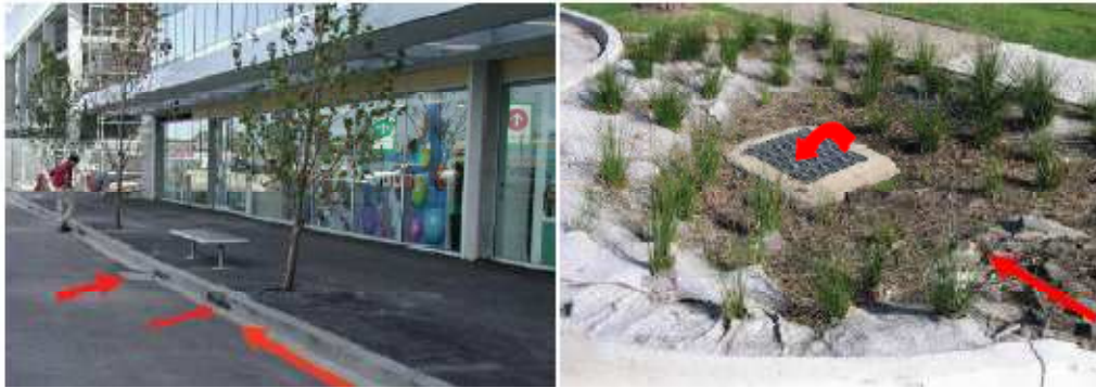
Figura 7.7 – Sistemas de biorretenção em árvores nas calçadas e em pequenas bacia de retenção em faixas de estacionamento.
