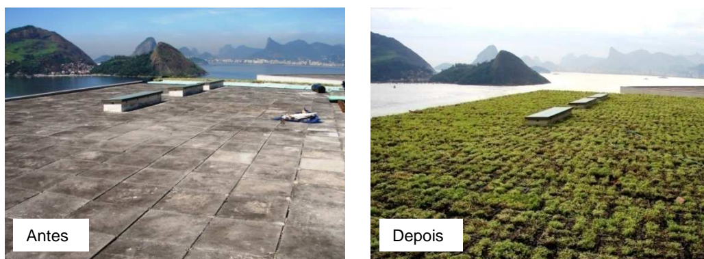
Figura 3.19: Aplicação de telhados verdes no Rio de Janeiro.
