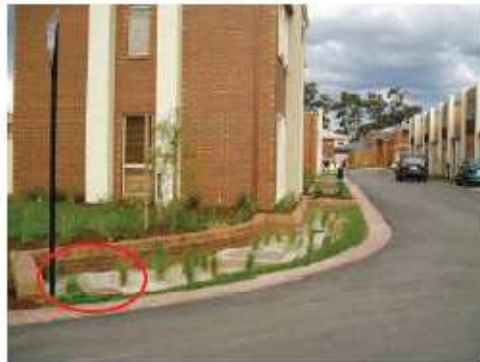
Figura 5.8 – Exemplos de aplicação biofiltros em canteiros públicos e em lote.
