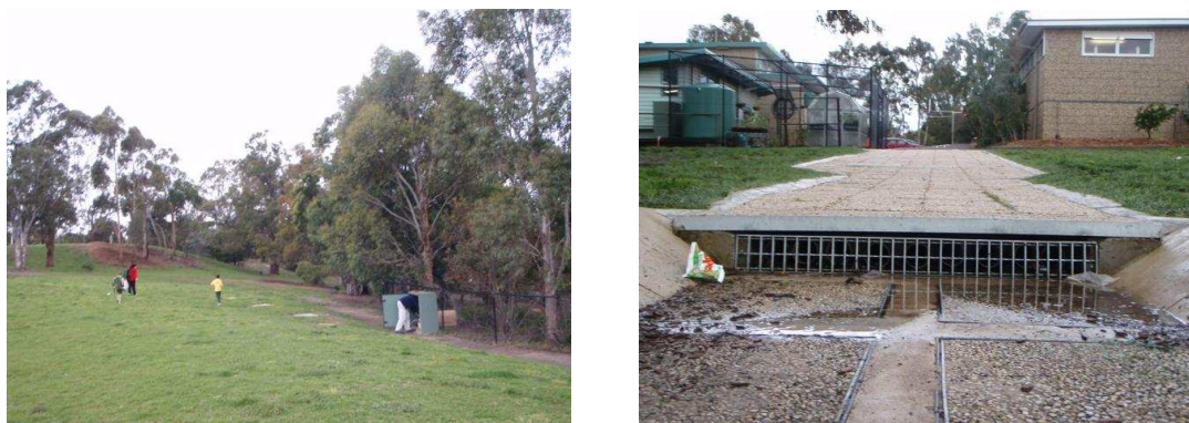
Figura V.B – Detalhe do pavimento poroso (à esquerda) e cisterna de armazenamento da água tratada sob área gramada de recreação (à direita).
