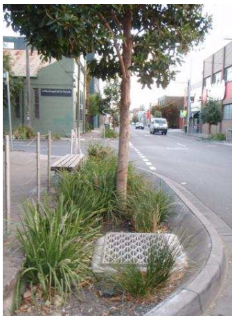
Figura III.A – Sistema de bioretenção nas ruas do bairro de Richmond.
