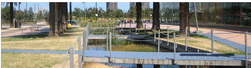
Figura 3.12 – Alagados Construídos no calçadão do prédio do banco NAB (Docklands, Melbourne, Austrália).
