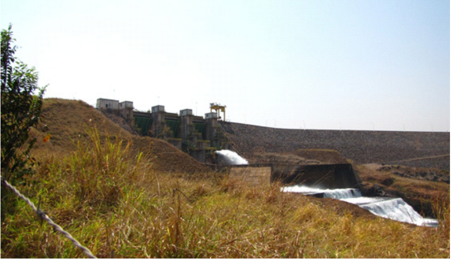
Figura 3: Vertedor fechado e operação da vazão com abertura de válvula na UHE Capim Branco
