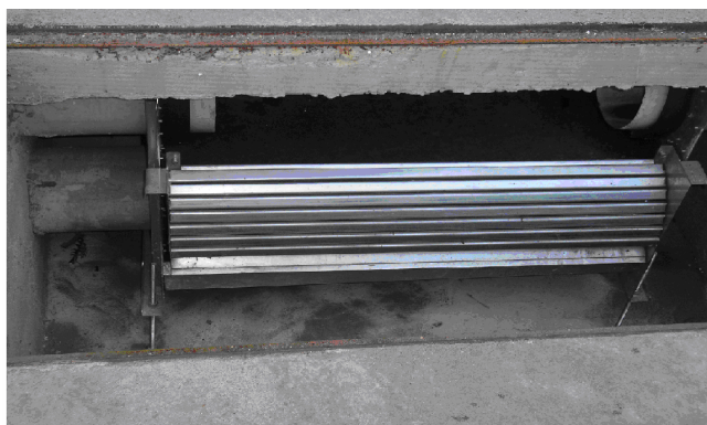
Figura 4-3 – Fotografia de um dos filtros VF6 da 3P Tecnick instalados na Cidade do Samba
